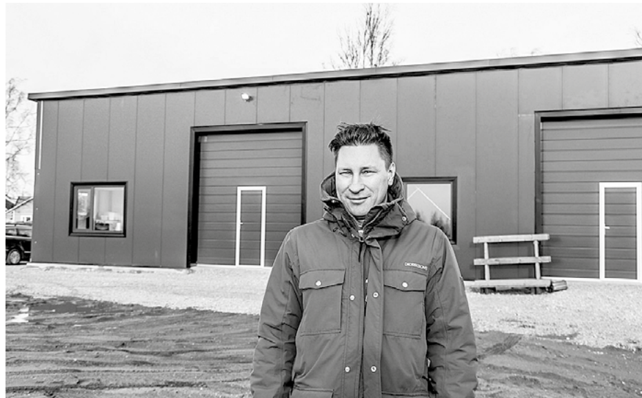
Salacgrīvietis Jānis Bergs uzskata – lai veiksmīgi piesaistītu LEADER finansējumu uzņēmējdarbības attīstībai, jātic savai iecerei un jābūt pilnībā pārliecinātam par mērķi, ko vēlies sasniegt
